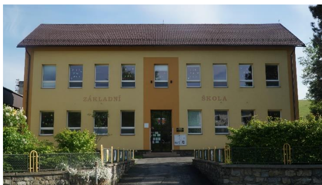
Budova základní školy
